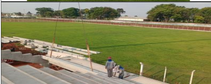
Foto 7 e 8: Serviços de instalação dos materiais fabricados, conforme memorial descritivo e planilhas de serviços. Autor: Município de Campo Mourão. Data: outubro de 2024.
