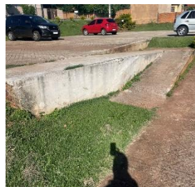
Foto 5: Rampa de saída do estacionamento em Cornélio Procópio.
