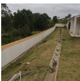
Foto 42: Muro de fundo baixo no residencial de Prudentópolis.
