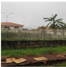
Foto 44: Cerca de fundo em Foz do Iguaçu com estrutura que facilita a transposição.
