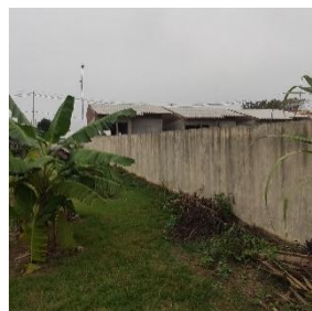
Foto 39: Muro baixo no residencial de Foz do Iguaçu.
