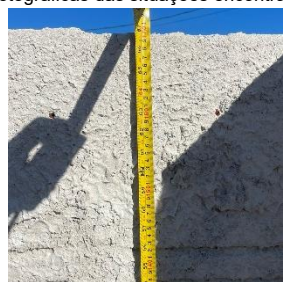
Foto 37: Muro com altura de 1,70 m no residencial em construção em Arapongas.
