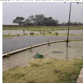
Foto 31: Alagamento durante chuva no residencial de Cornélio Procópio.
