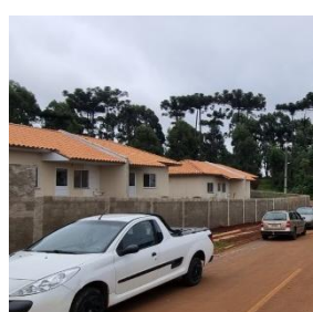
Foto 41: Muro frontal baixo do residencial de Ponta Grossa.
