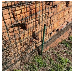
Foto 43: Trecho de cerca de Cornélio Procópio fixada com cabo de vassoura.
