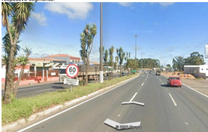
Km 175, da BR 373, sentido norte. Em 2022, o segmento está revestido com Gap Graded, que substituiu o TSD. Por isso, agora, a textura é menos rugosa.
