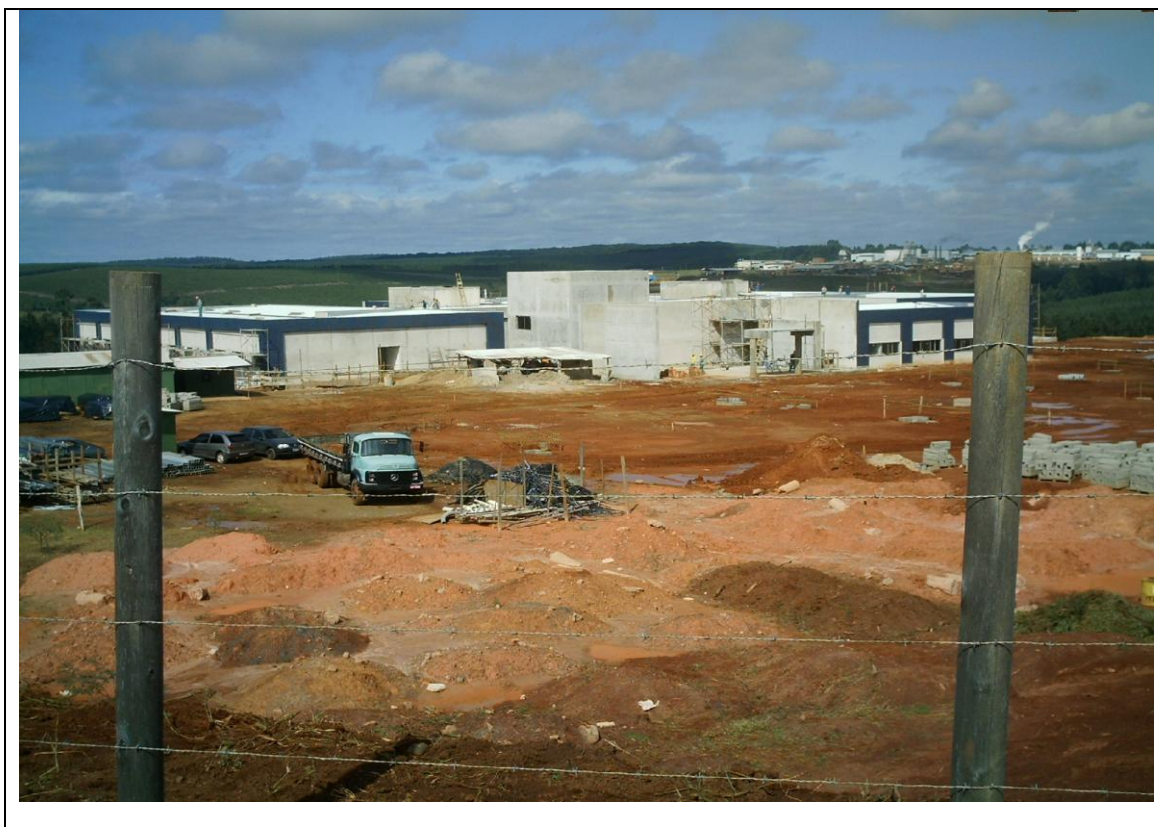
Foto 15 – Vista da construção do Hospital Regional de Telêmaco Borba – 30 de abril de 2010.
