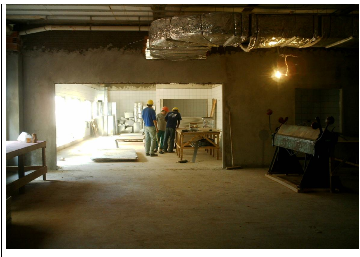
Foto 16 – Construção do Hospital Regional de Telêmaco Borba, vista do refeitório em direção à cozinha – 30 de abril de 2010.
