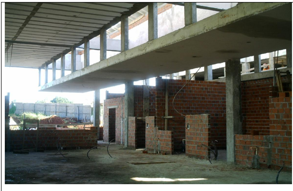
Foto 25 – Construção do Bloco Industrial no Hospital Universitário de Maringá. Recursos SESA - 27 abril de 2010.
