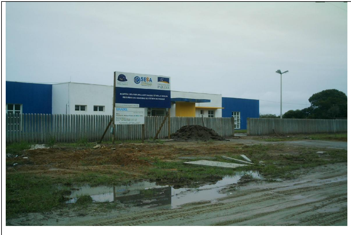
Foto 17 – Vista da fachada principal do Hospital de Guaraqueçaba – 2 de junho de 2010.
