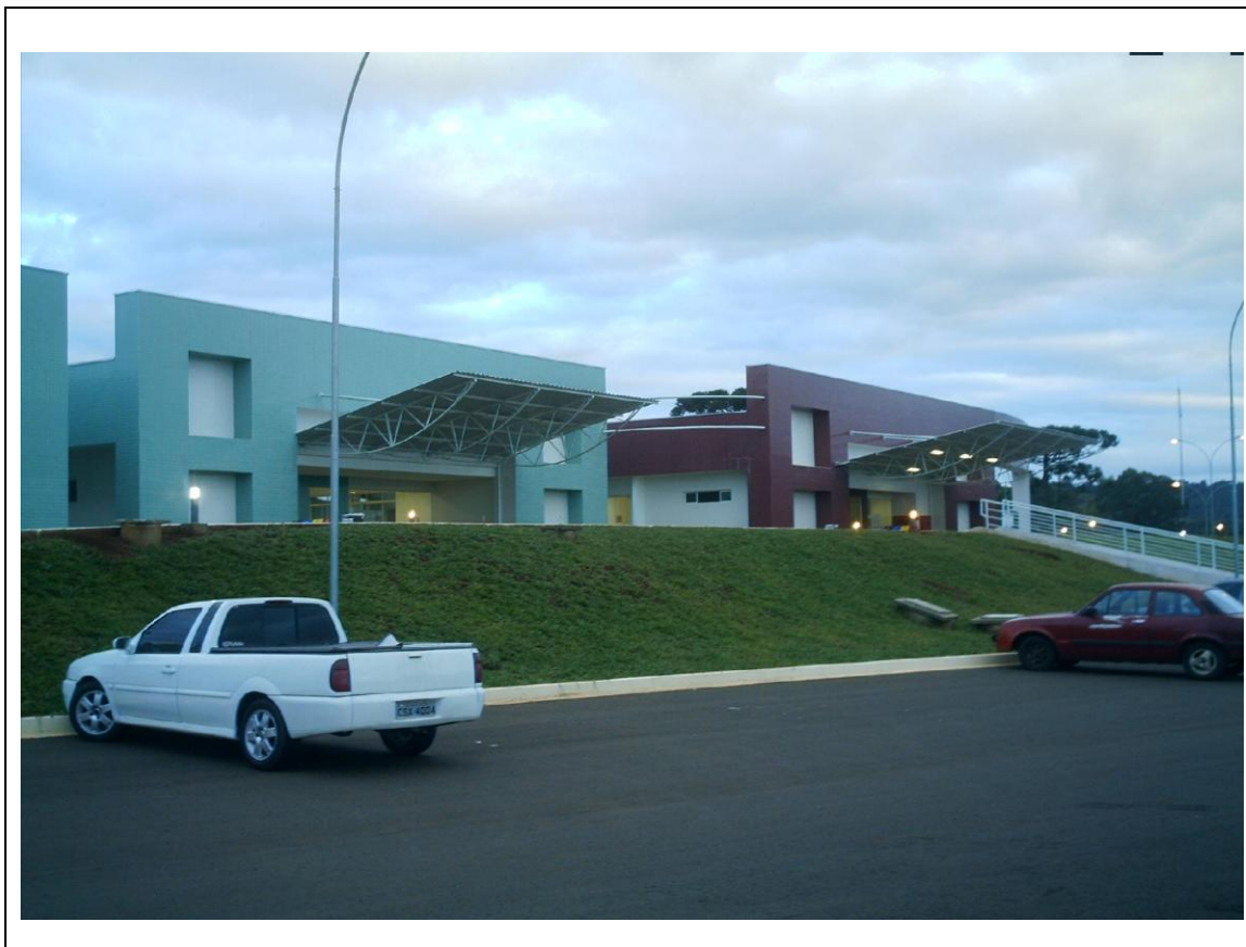
Foto 11- Fachada principal do Hospital Regional de Francisco Beltrão – 4 de maio de 2010.
